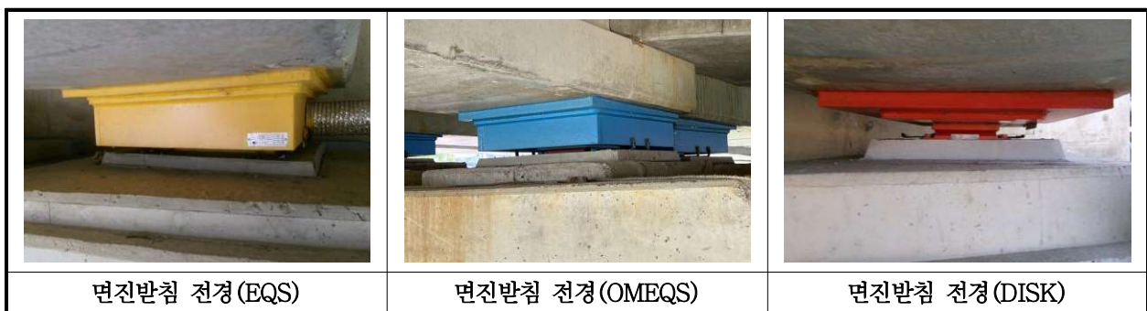
【사진 19.3.12】 교량받침 전경
