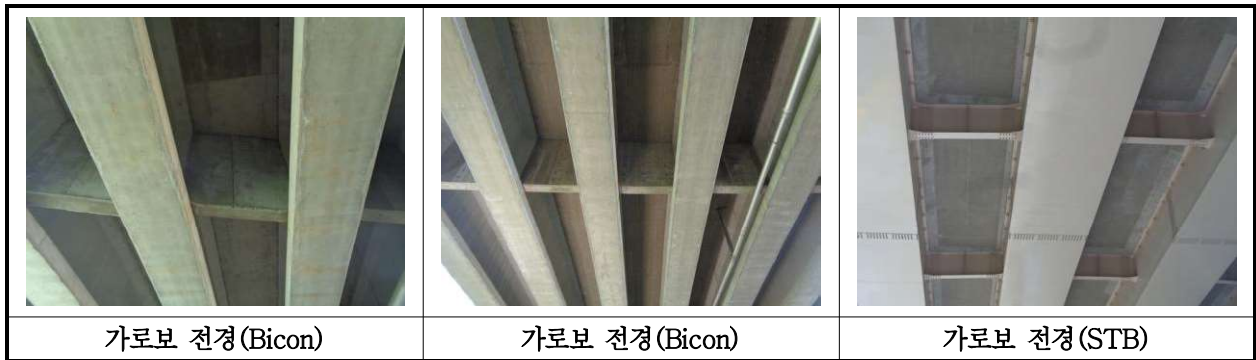
【사진 19.3.6】 가로보 전경
