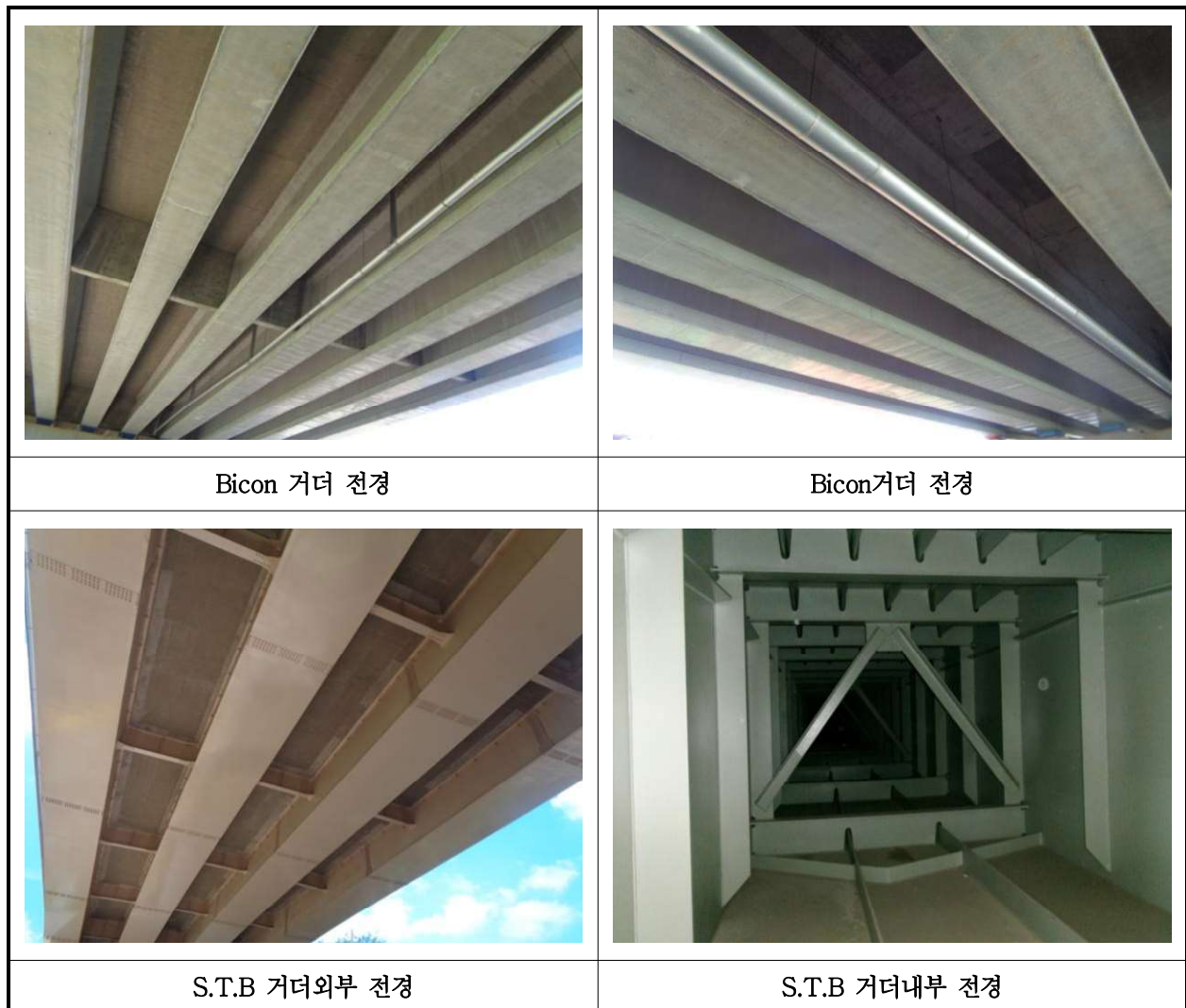
【사진 19.3.4】 거더 전경
