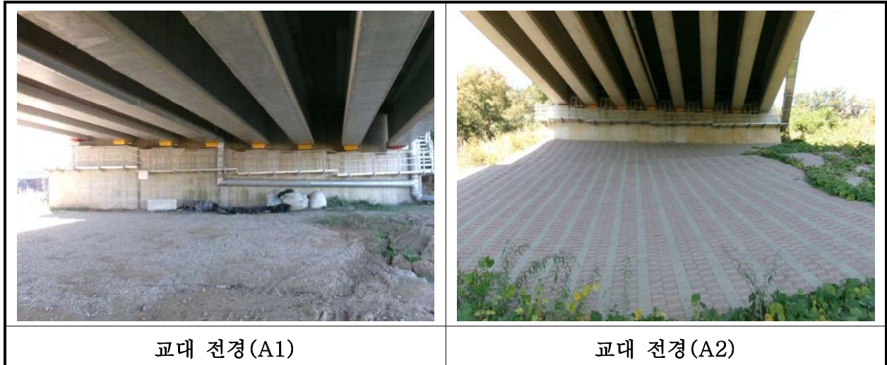
【사진 19.3.8】 교대 전경
