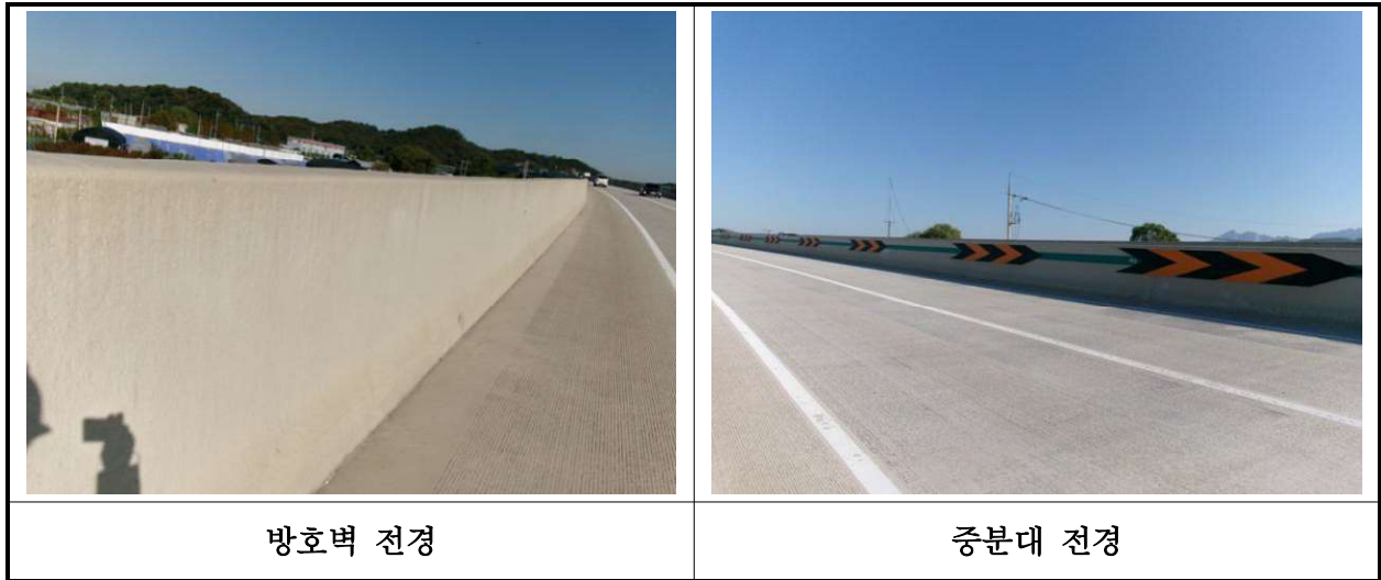
【사진 19.3.23】 방호벽 및 중앙분리대 전경
