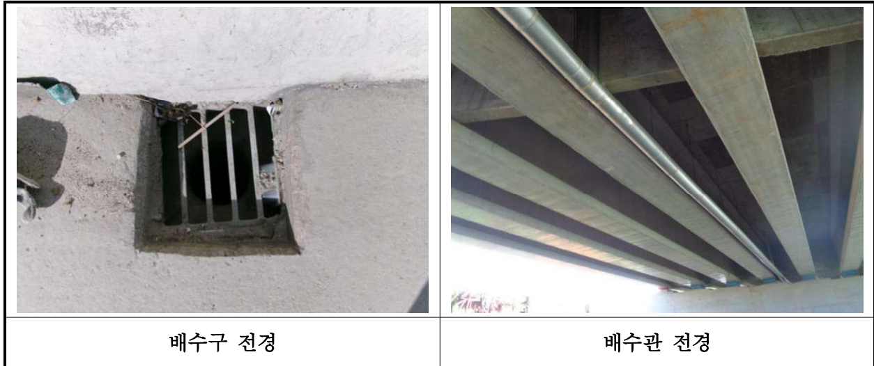
【사진 19.3.21】 배수시설 전경
