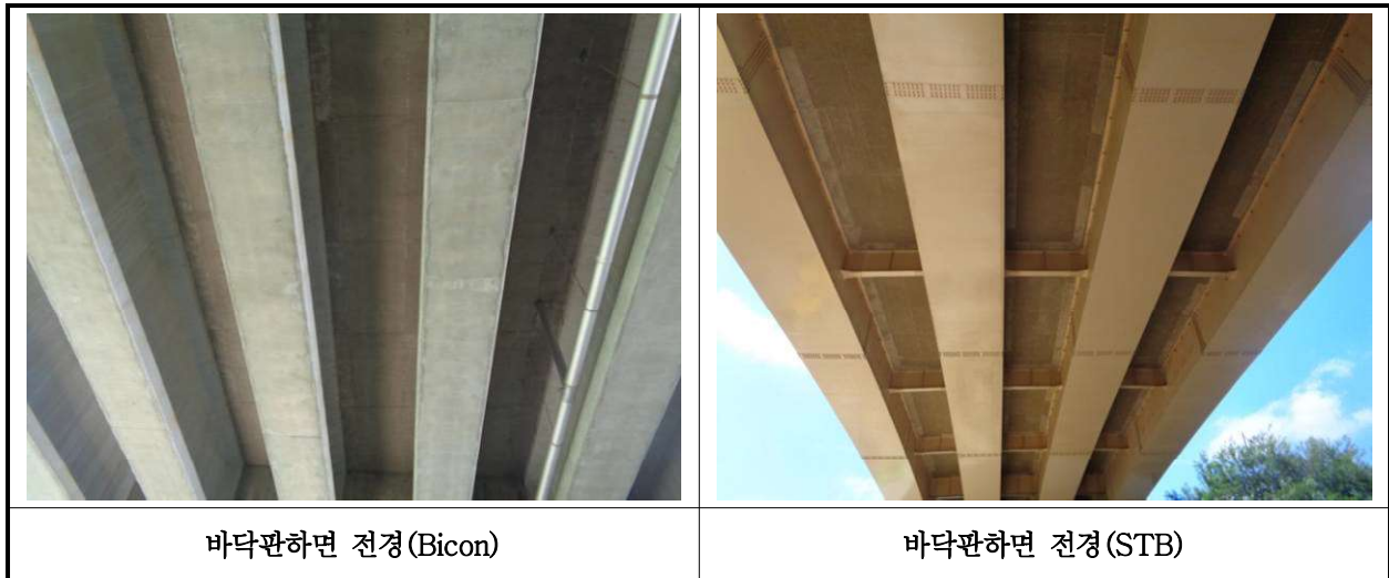
【사진 19.3.2】 바닥판하면 전경
